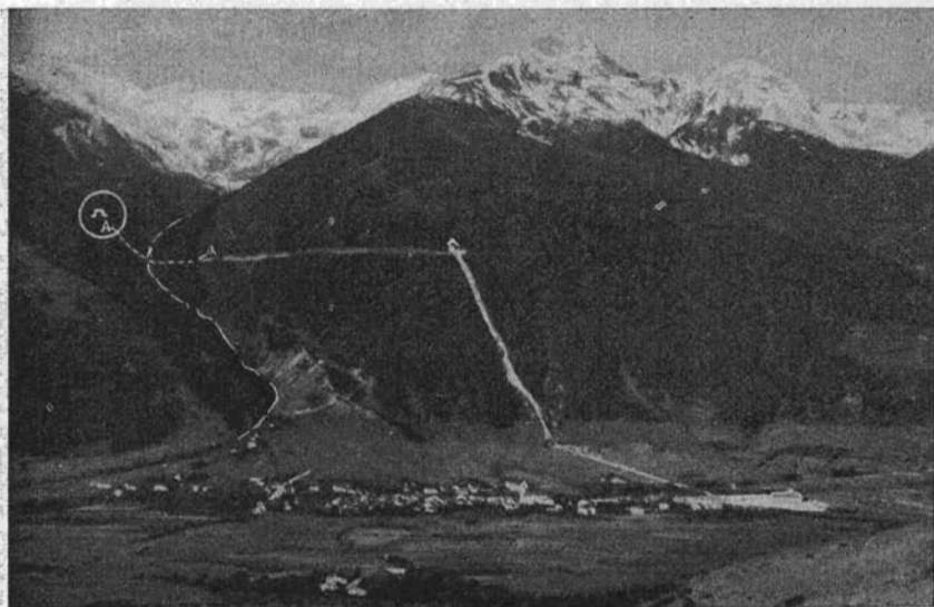
Lasa, lo stabilimento della Lasa-Marmi ed il sistema di trasporti dalle gallerie, a 1600 m, dei blocchi estratti. (foto CONSIGLIO)
