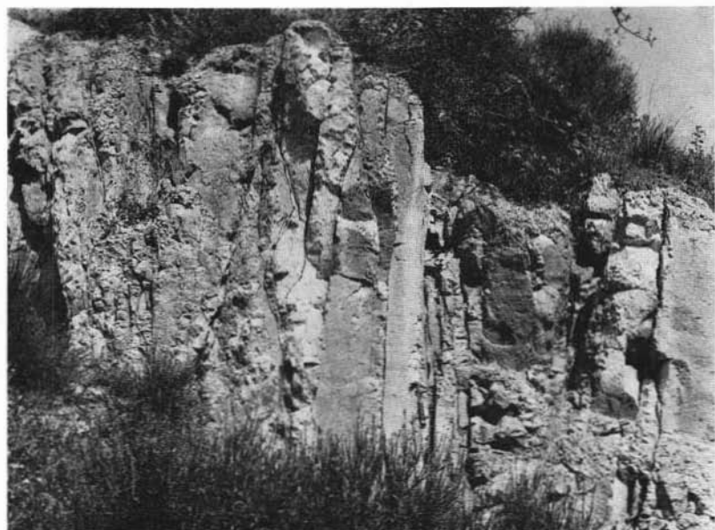
Fig. 2. — Piano di Croce . E' evidente la fessurazione prismatica.
