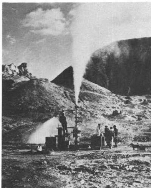
Fig. 9. — Pozzo VU 2 bis: erogazione con « tubing » dopo 2,5 anni di produzione continua.
