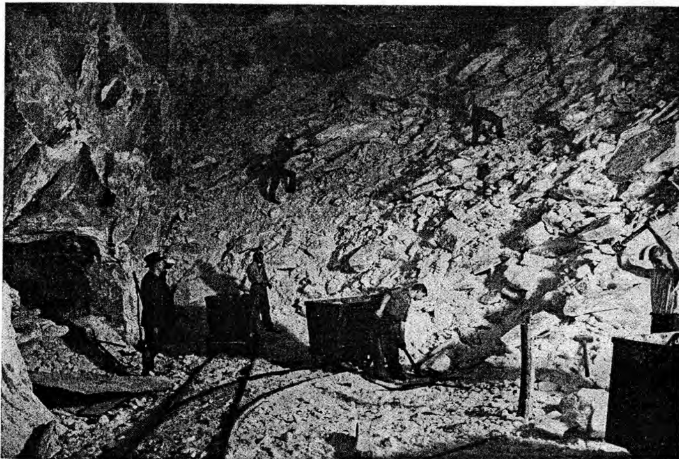
Fig. 130. Solvayhall I. Steinsalzfirst im jüngeren Steinsalz.
